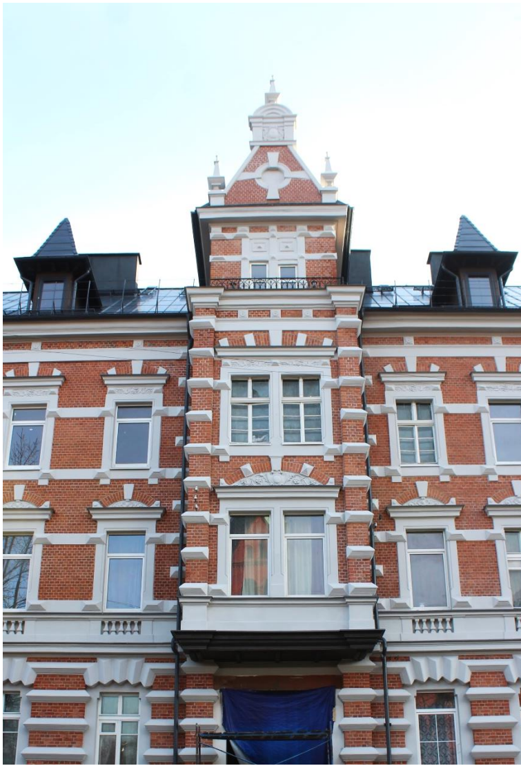
Работа с новыми видами исторических кровельных покрытий: сланец
